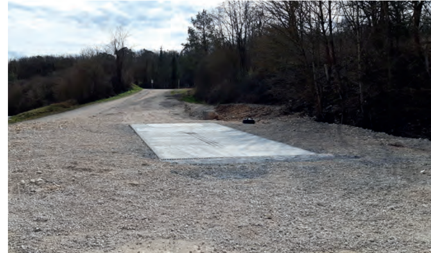
L'aire étanche sur le site ▲
