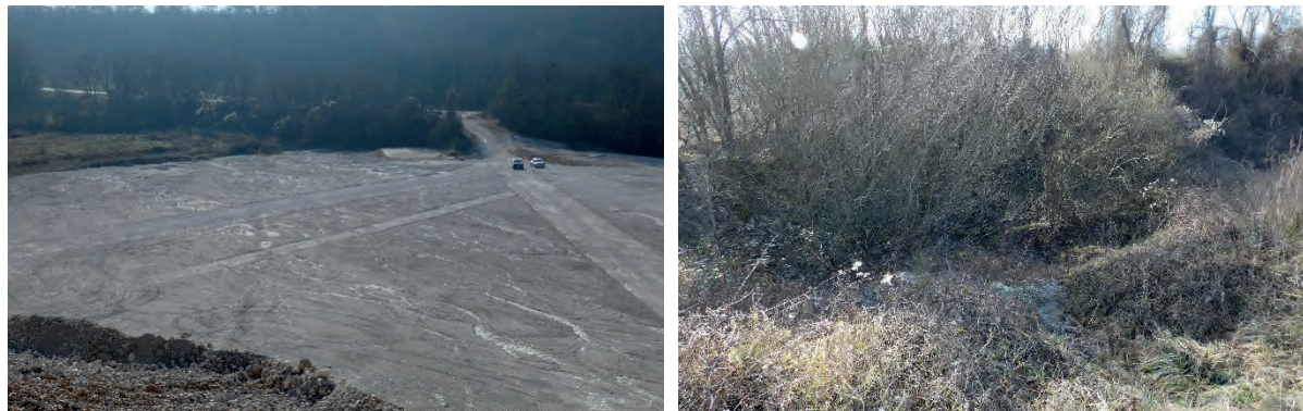
Les axes préférentiels de ruissellement sur le carreau et le point bas de collecte des eaux de ruissellement ▲
