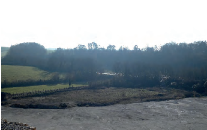
▲ La zone de dépôt de matériaux stériles
